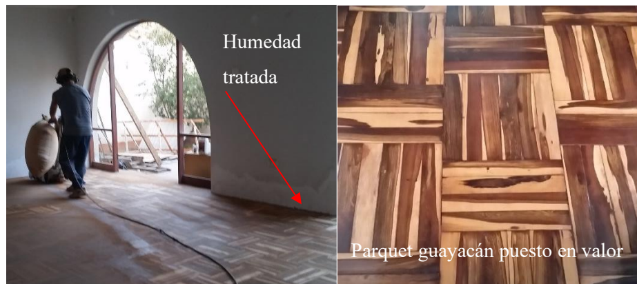
Parquet guayacán, puesto en valor luego de tratarse la humedad por capilaridad en paredes del inmueble en remodelación.
