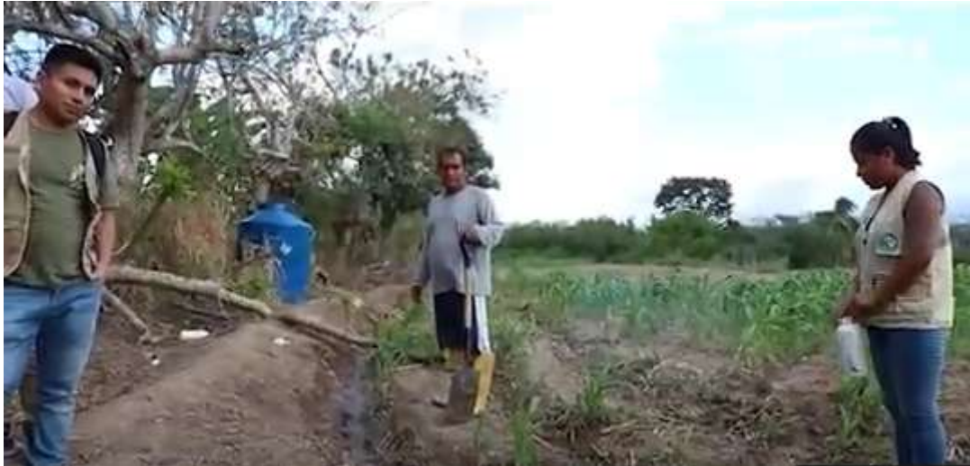
Figura 14. Instalación de bomba de ariete sector Huaquillas-Bagua-Amazonas Fuente: Elaboración propia
