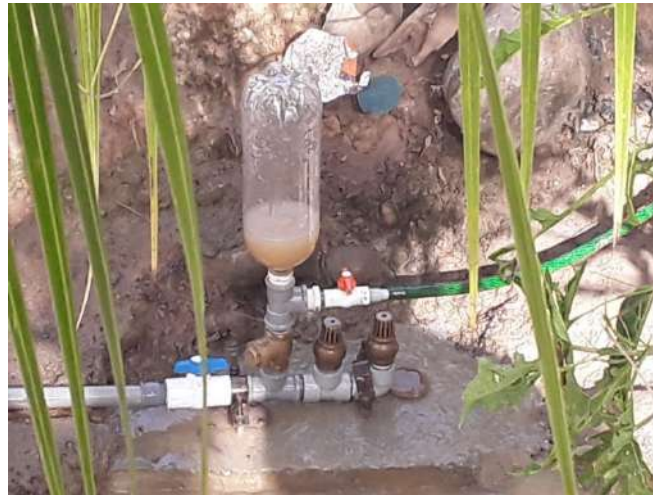
Figura 10. Instalación de bomba de ariete Las Juntas-Bagua-Amazonas Fuente: Elaboración propia
