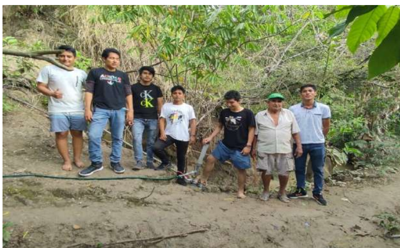
Figura 13. Instalación de bomba de ariete Achahuay Bajo-Bagua-Amazonas Fuente: Elaboración propia
