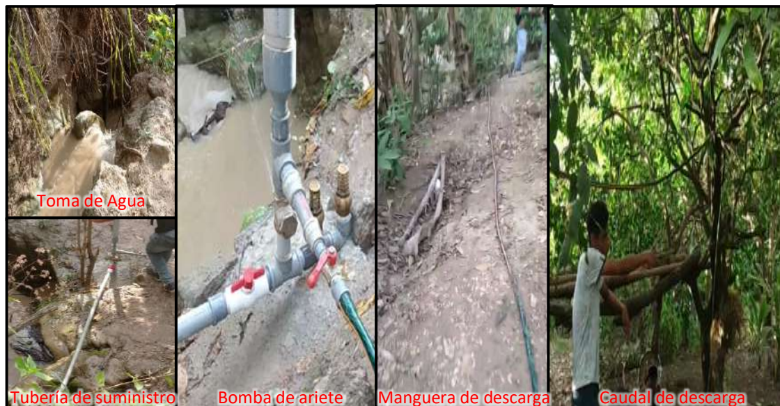
Figura 7. Pruebas hidráulicas Achahuay Bajo-Bagua-Amazonas Fuente: Elaboración propia
