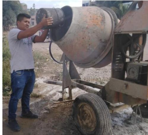
Figura 5. Figura 6. Elaboración de concreto sin aditivo.
